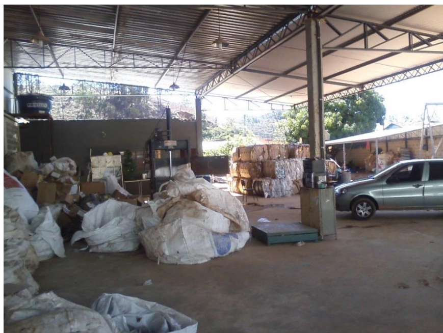
Figura 4.3: Galpão coberto da ACIMAR de 286 m 2 e estocagem de fardos. Ao fundo, o galpão menor de 125m 2 .
