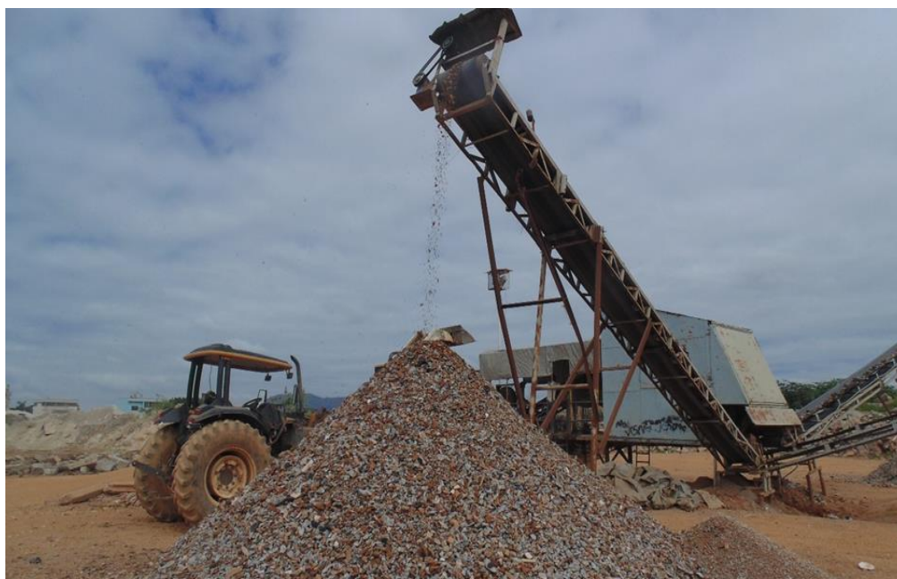
Figura 16 Usina de Reciclagem de RCC em Pouso Alegre
