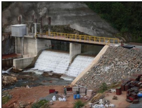
Figura 6: Barragem da PCH Cristina.
