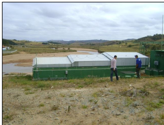
Figura 10: Casa de Máquinas da PCH Oliveira.
