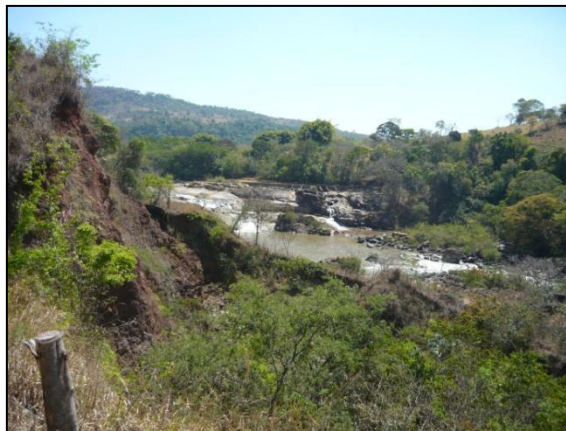
Figura 12: Barramento da antiga PCH na área em que será instalada a PCH Tuneco Alta.
