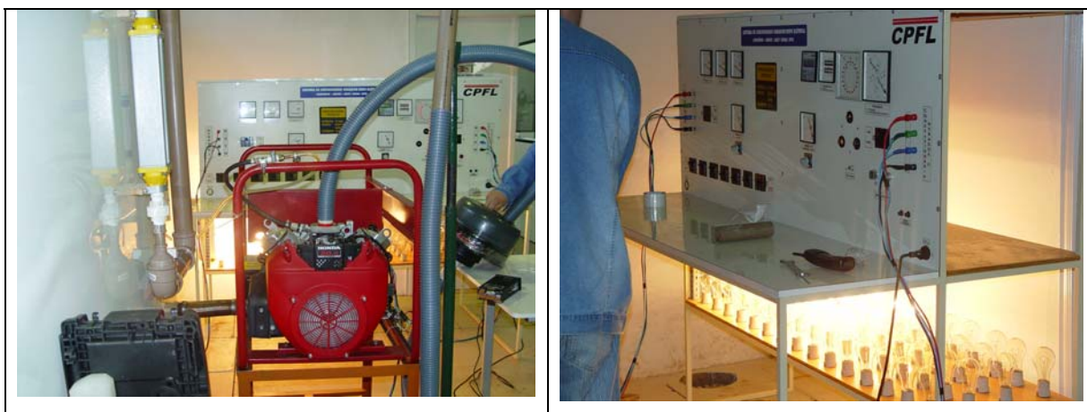
Figura 10.11 Operação do moto-gerador com gás de biomassa.
