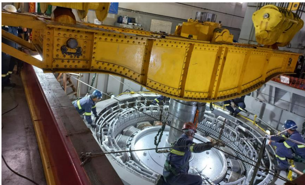
Figura 5 - Rotor e estator (Fonte: Própria).
