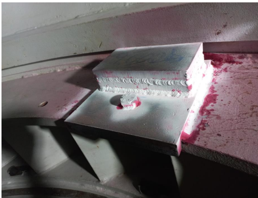
Figura 48 - Peso de balanceamento instalado no rotor gerador. (Fonte: própria)
