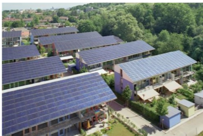
Figura 9: Sistema Fotovoltaico tipo BIPV
