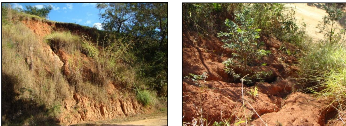
Figura 5.14: Deslocamento de massa em corte de estrada, área degradada D13.
