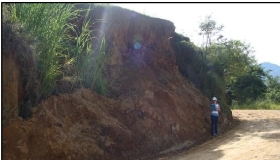
Figura 5.9: Deslocamento de massa em corte de estrada, área degradada D8.
