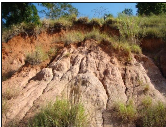
Figura 5.11: Deslocamento de massa em talude artificial, área degradada D10.
