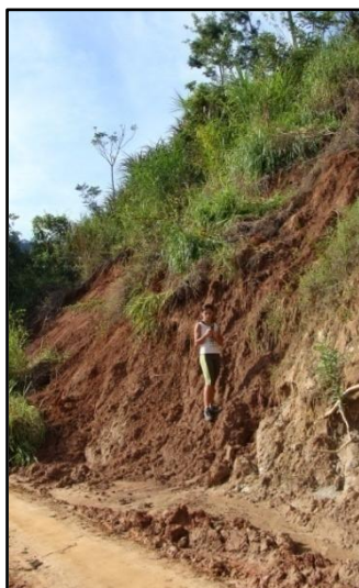
Figura 5.12: Deslocamento de massa em corte de estrada, área degradada D11.
