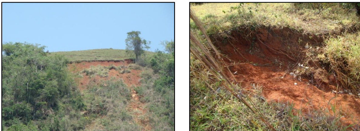
Figura 5.18: Deslocamento de massa em encosta, área degradada D17.
