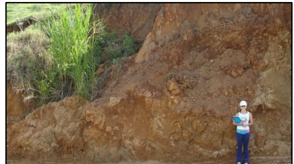
Figura 5.9: Deslocamento de massa em corte de estrada, área degradada D8.
