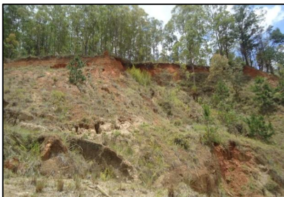
Figura 5.20: Deslocamento de massa em talude de corte, área degradada D19.
