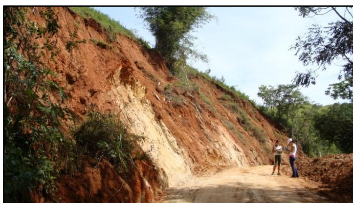
Figura 5.7: Deslocamento de massa em corte de estrada, área degradada D6.
