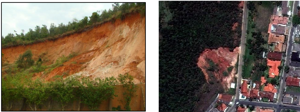
Figura 5.21: Deslocamento de massa em talude, área degradada D20.
