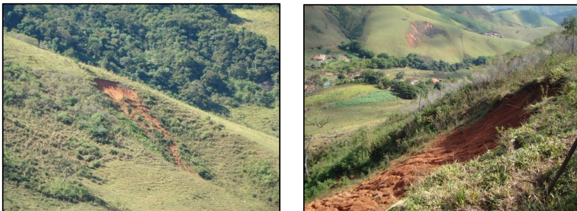
Figura 5.16: Deslocamento de massa em encosta, área degradada D15.
