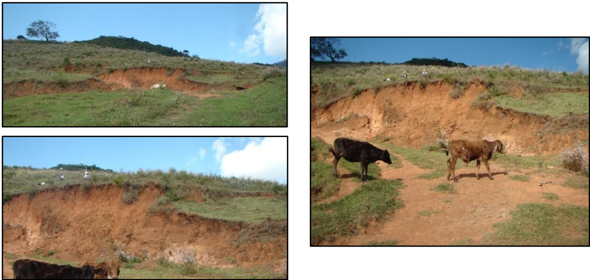
Figura 5.2: Deslocamento de massa em corte de estrada, área degradada D1.
