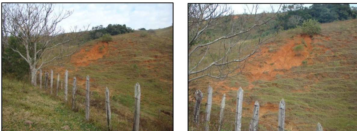
Figura 5.17: Erosão laminar, área degradada D16.
