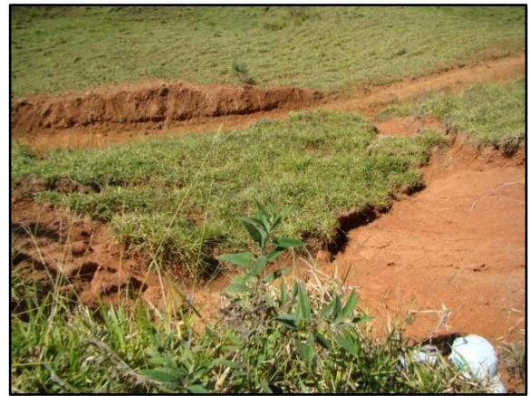
Figura 5.8: Deslocamento de massa em corte de estrada, área degradada D7.
