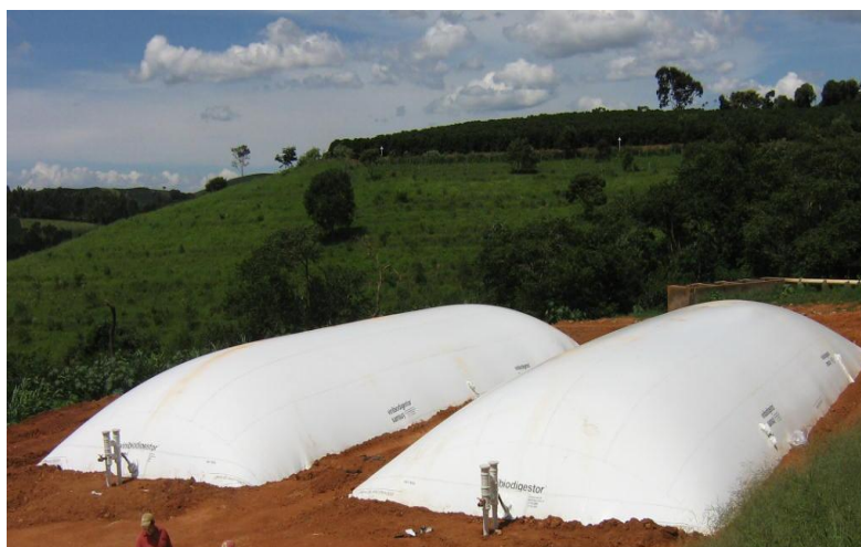
Figura 2.6 - Biodigestor de fluxo tubular ou do tipo marinha Fonte: IFSMG – Campus Muzambinho
