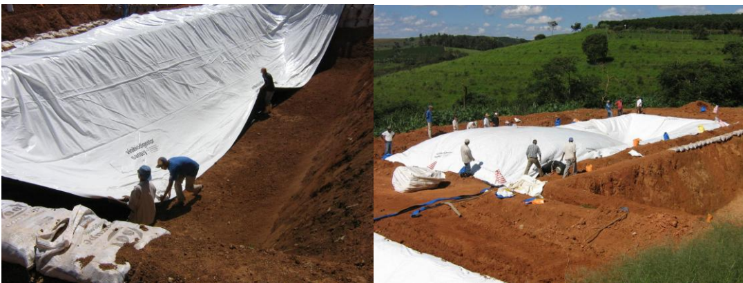
Figura 3.4 - Montagem dos biodigestores
