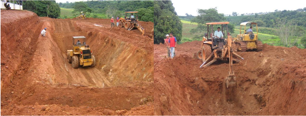
Figura 3.3 - Escavação dos biodigestores
