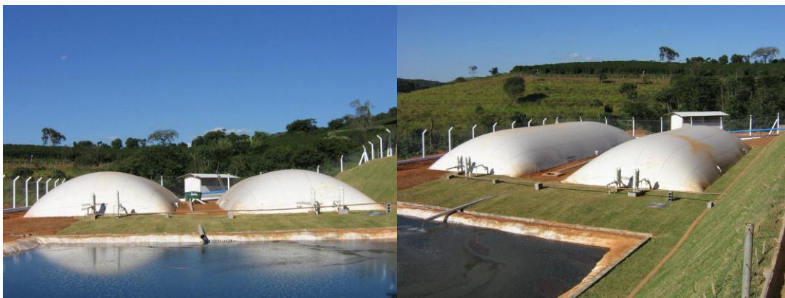
Figura 3.6 - Biodigestores em pleno funcionamento
