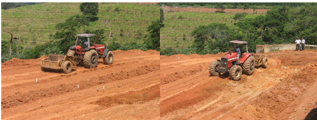
Figura 3.2 - Trator com scraper iniciando a terraplanagem.
