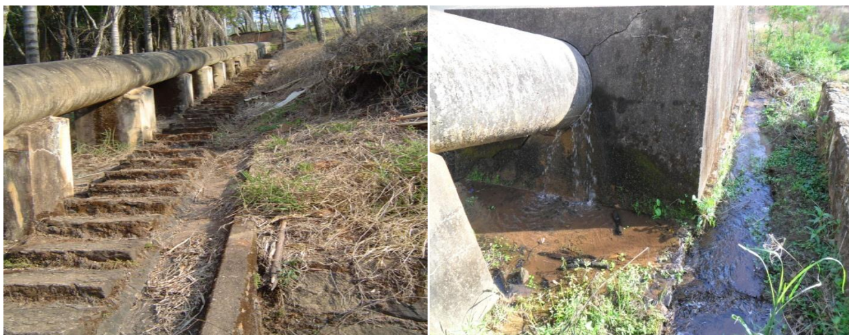
Figura 2.13 - Blocos de apoio e ancoragem
