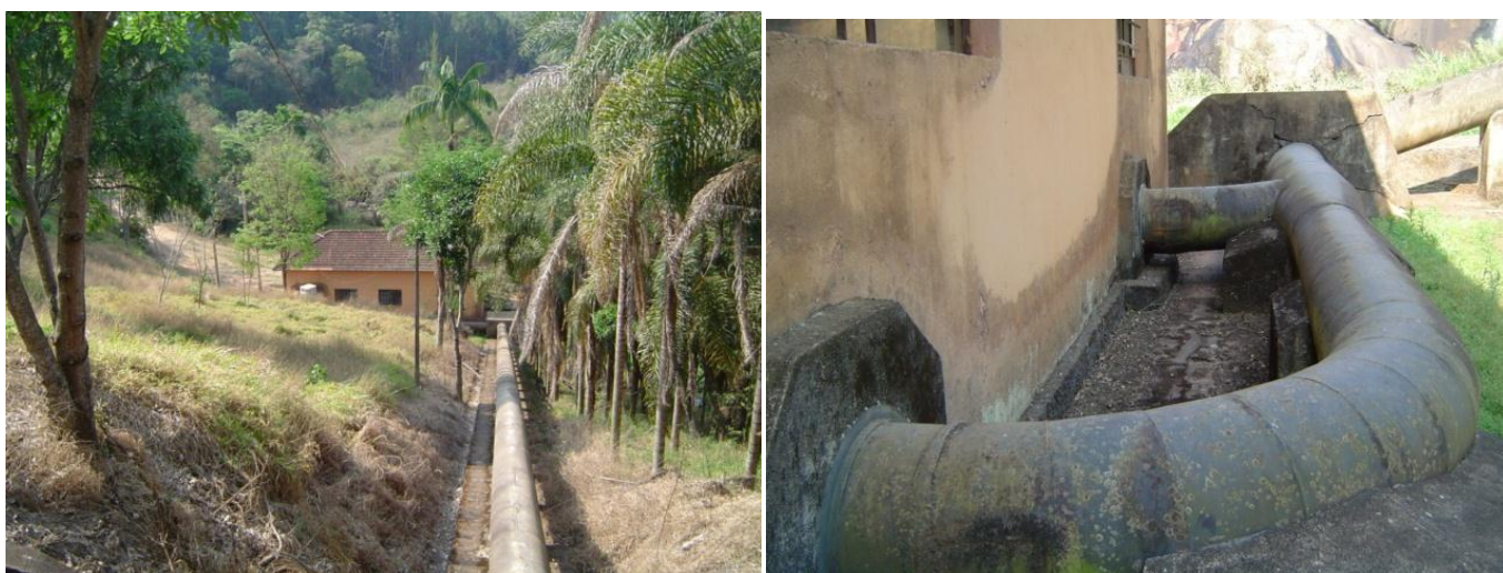
Figura 2.12 - Conduto forçado
