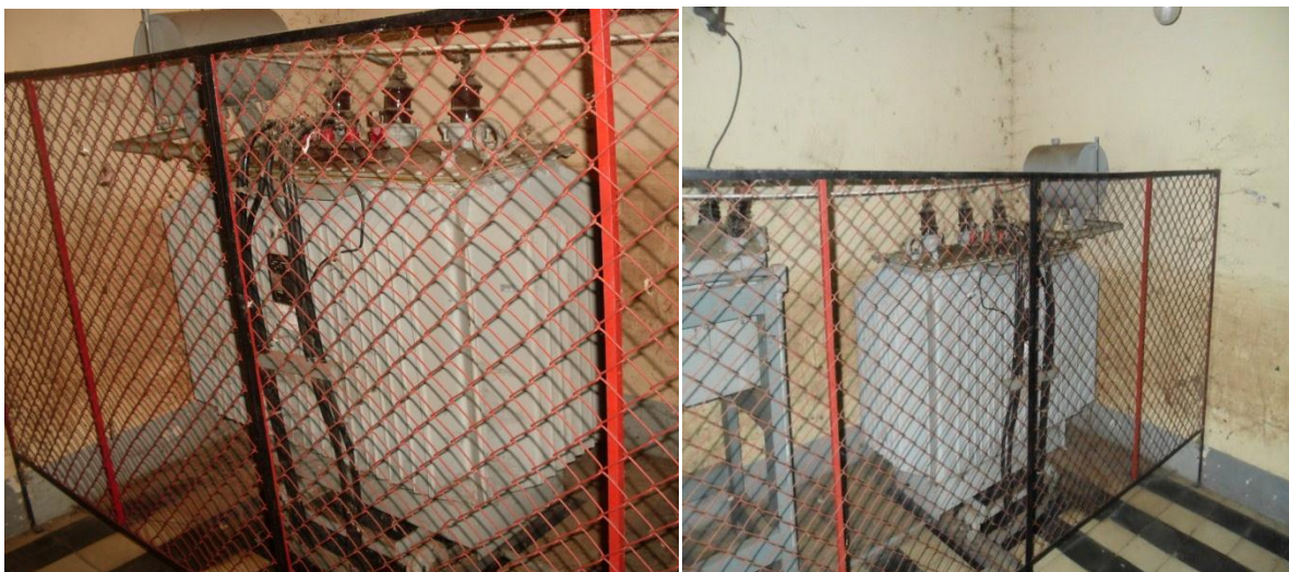
Figura 2.18 - Transformador elevador
