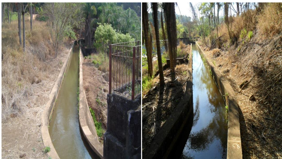
Figura 2.10 - Canal de adução
