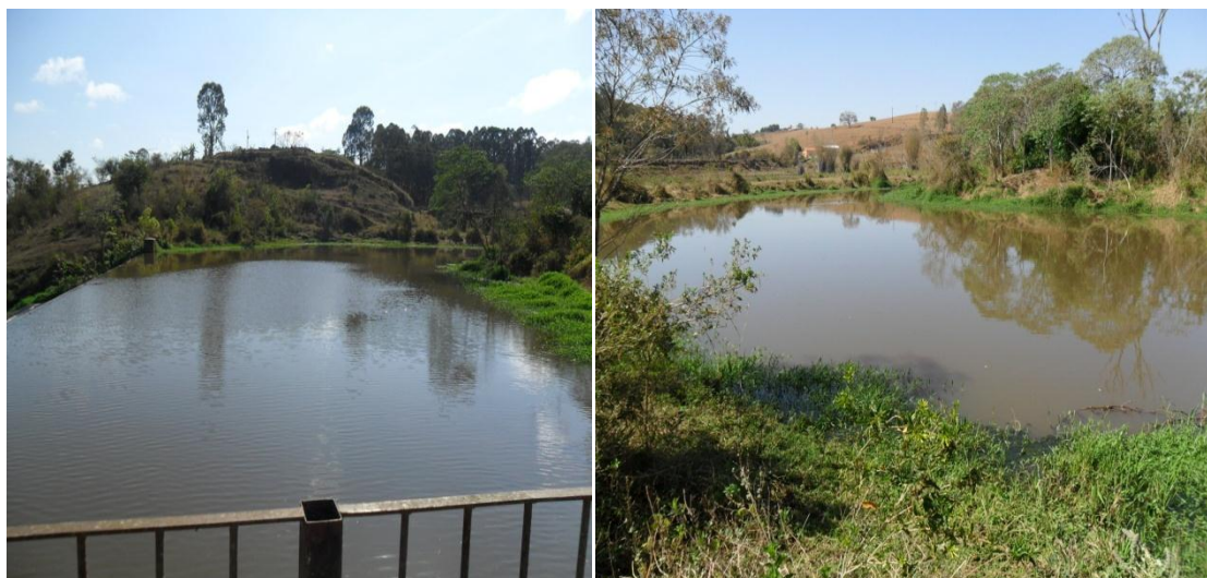
Figura 2.7 - Reservatório da Central
