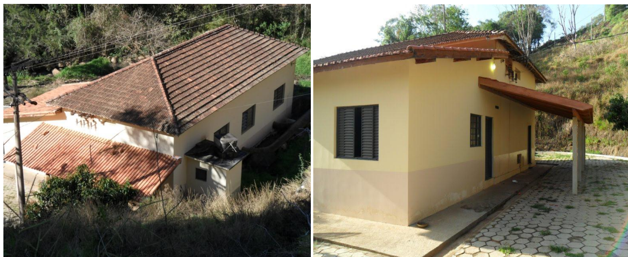
Figura 2.14 - Casa de máquinas
