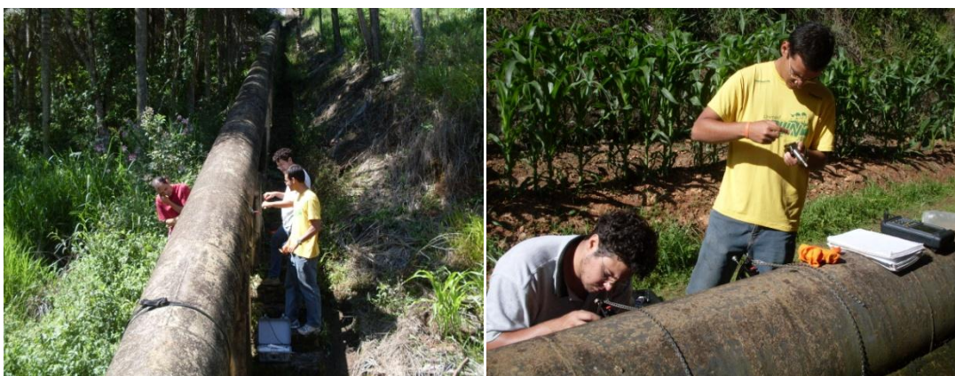
Figura 4.3 - Medidas de vazão por ultrassom.
