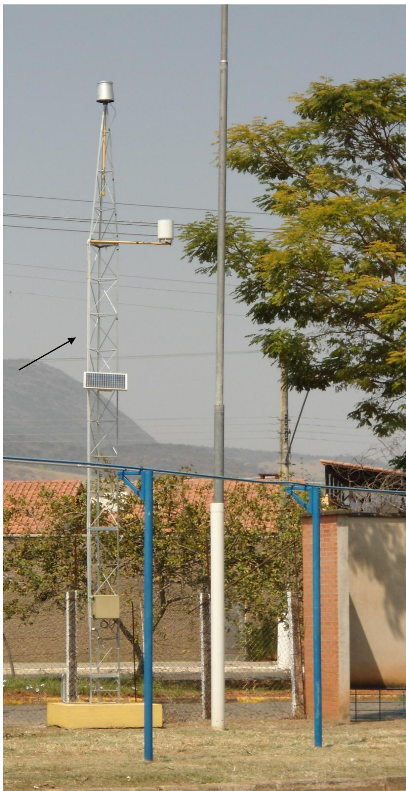
Apêndice 10: Estação de monitoramento de enchente – “Estação UNIFEI”. (Fonte: autor)
