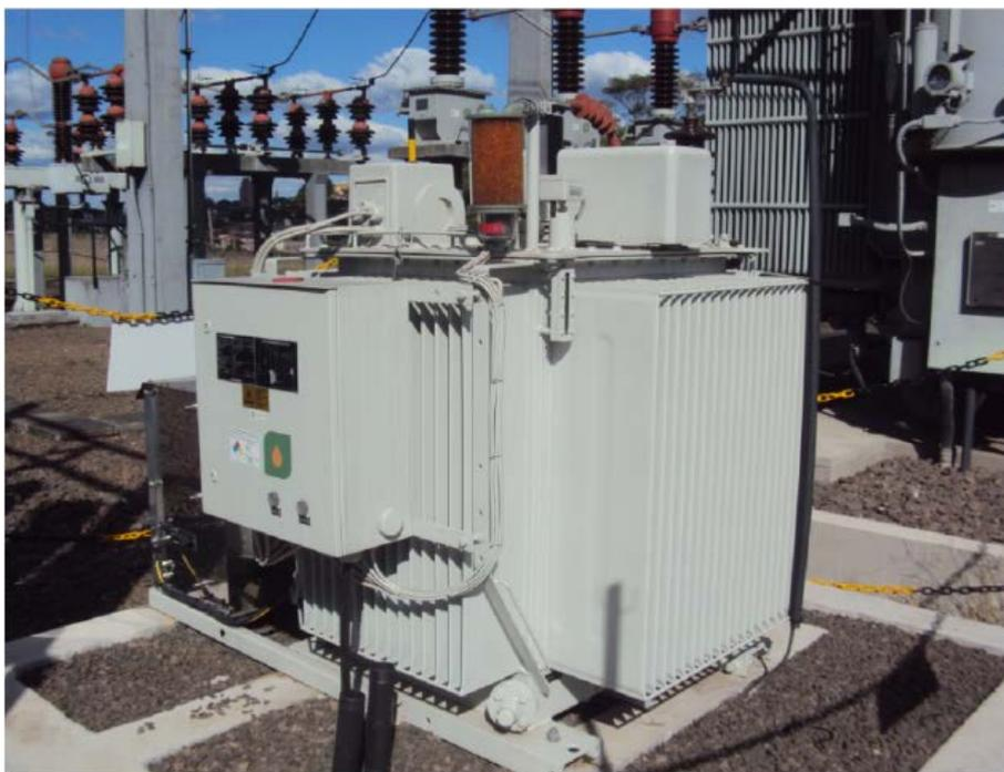
**Figura 1 - Bobina de Petersen instalada na subestação de Novo Hamburgo, propriedade da AES Sul [8].**
