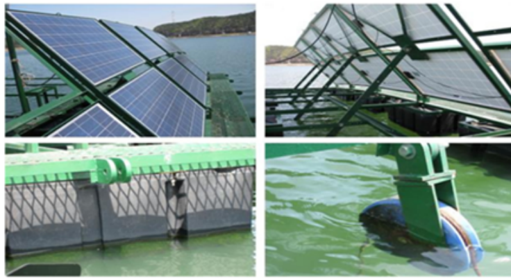
Figura 2.7 – Estruturas flutuante com suporte de aço
