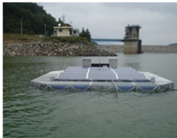
Figura 2.8 – Estruturas flutuante com suporte de polietileno
