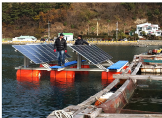
Figura 2.9 – Estruturas flutuante com suporte feito de materiais compósitos reforçados com fibra (FRP)
