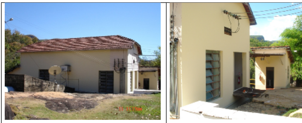
Figura 74: Casa de Máquinas da PCH Lajeado
