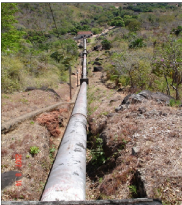
Figura 55: Vista parcial do conduto forçado da PCH Lajeado
