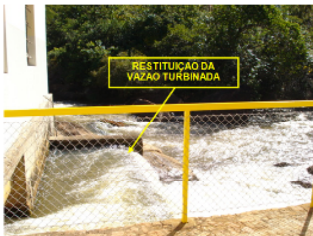
Figura 75: Canal de fuga
