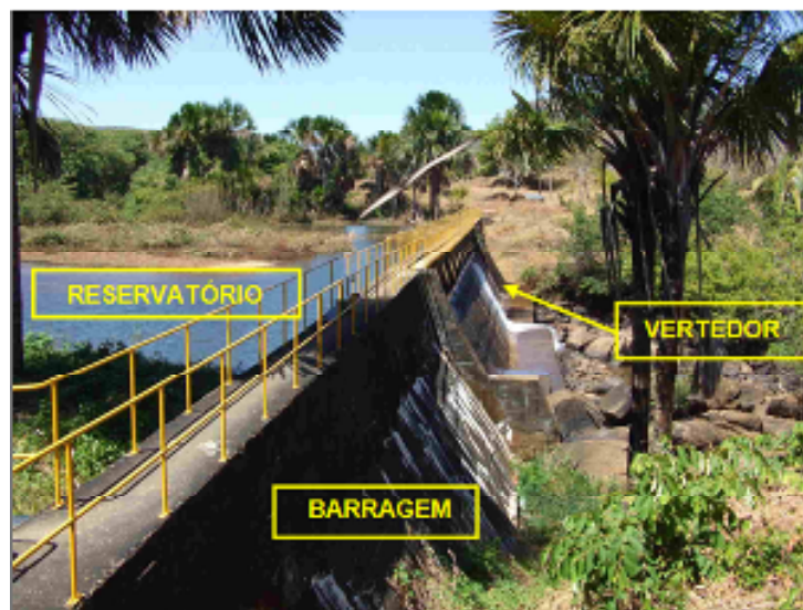
Figura 49: Vista parcial da barragem e do vertedor
