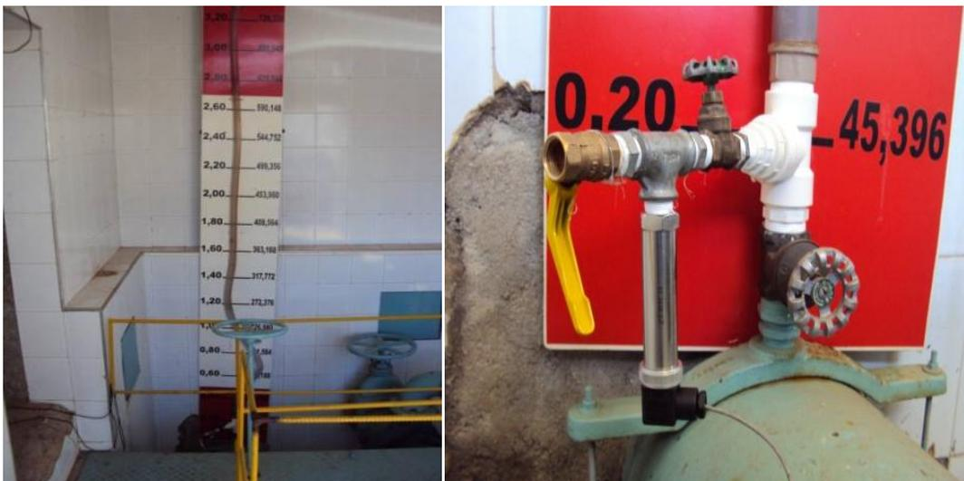
Figura 8.9. Medida de nível realizada no reservatório Vila Nova.
