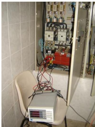
**Figura 8.8.** Wattímetro instalado no quadro de comando
