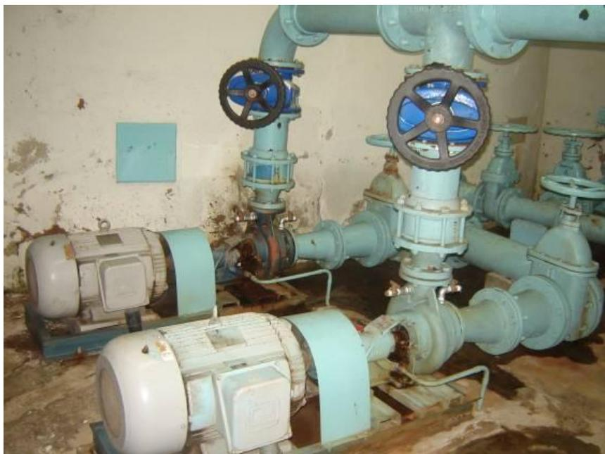
Figura 5.16 - Conjuntos motobombas do Solar dos Lagos
