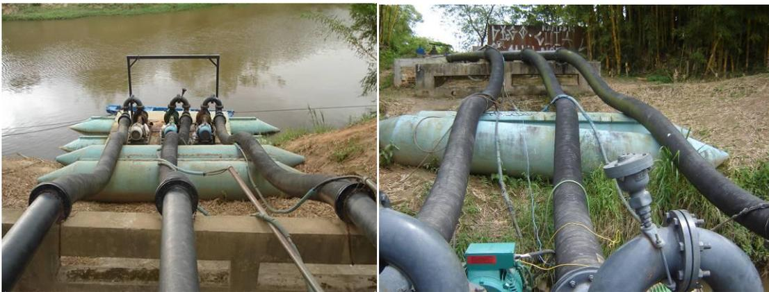
Figura 5.11 - Balsa de Captação e sua tubulação
