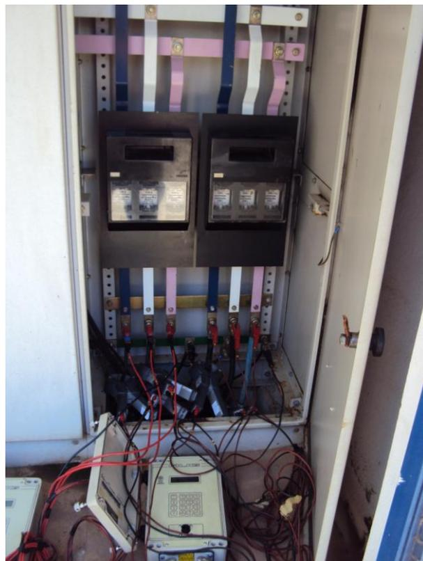
Figura 5.22 - Medições de parâmetros elétricos (Elevatória Vilanova)
