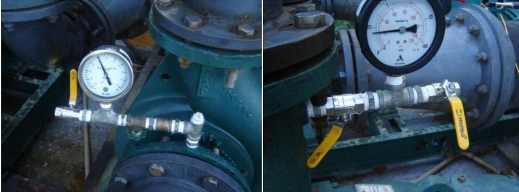
**Figura 8.7.** Medidas de pressão na entrada (esquerda) e saída (direita) da bomba.
