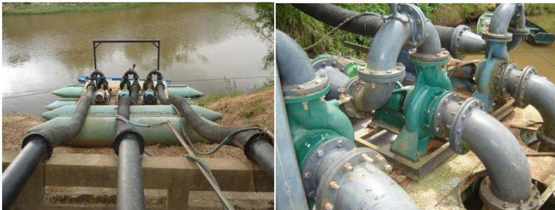
**Figura 8.2. Conjuntos moto bombas da captação.**
