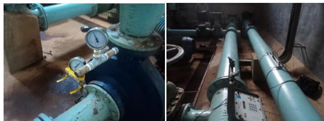
Fig. 7. Ensaios dos conjuntos motobombas e monitoramento de vazão para obtenção da curva de demanda.
