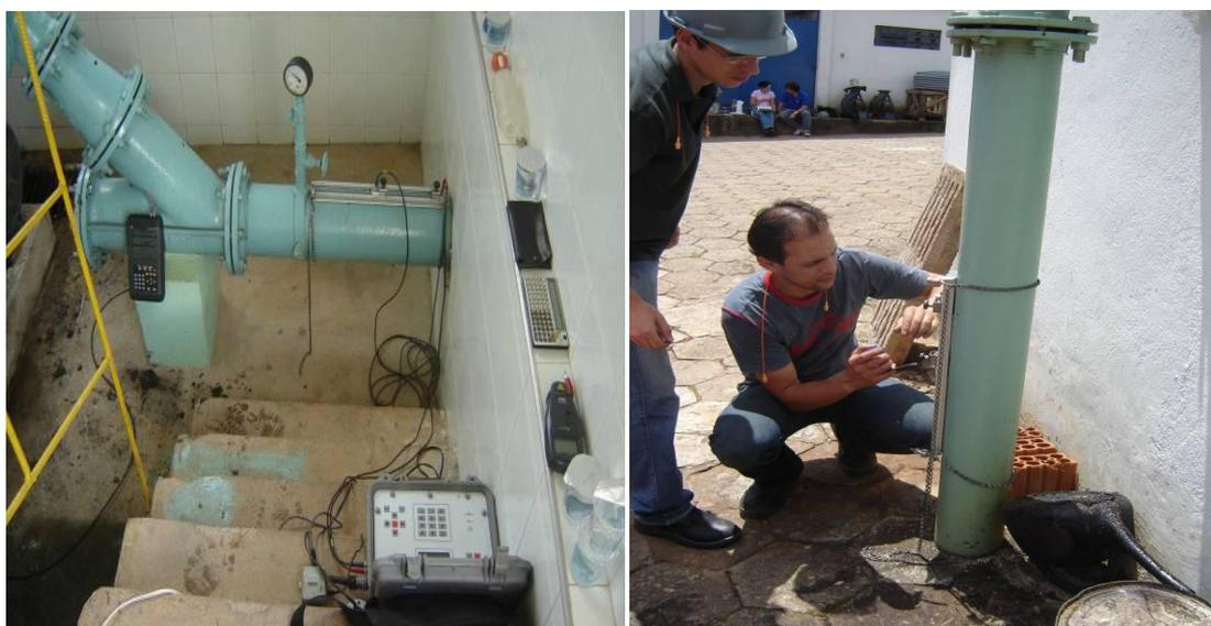
Figura 5.20 - Medições de vazão (Elevatória Vilanova)
