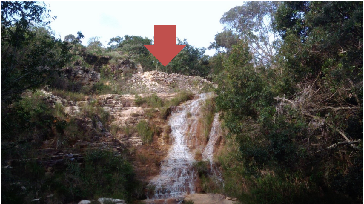
Figura 16 – Pilha de Rejeitos à Montante de Cachoeira
