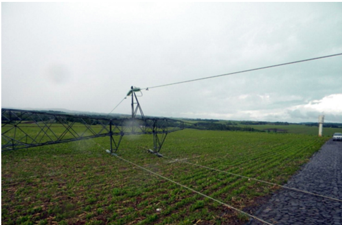
Figura 3.1: Queda de torre no Oeste do Paraná - Fonte Portal Medianeira
