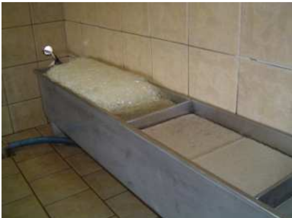
Figura 2. 13 - Decantador (Parte inicial).
