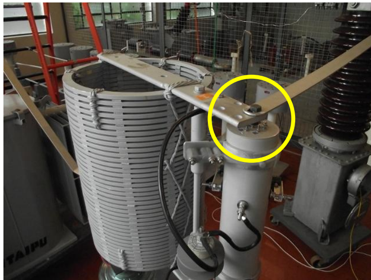
Figura 2.16 - Bobina de bloqueio com dispositivo de sintonia em destaque.
