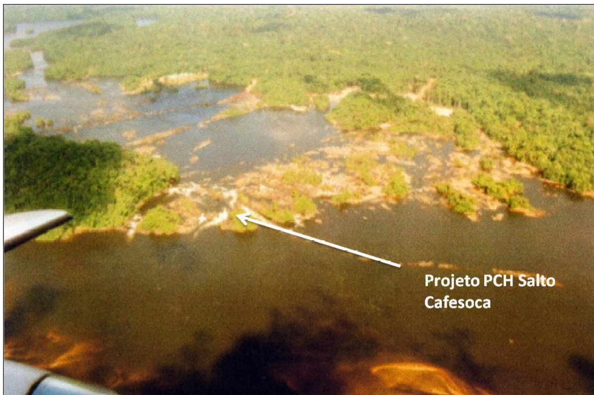
Figura 10.2 – Localização do da PCH Salto Cafesoca
