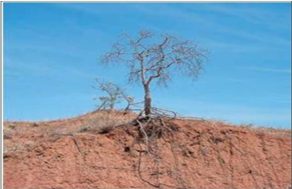
Figura 8 – Erosão laminar (IPEA, 2010).
