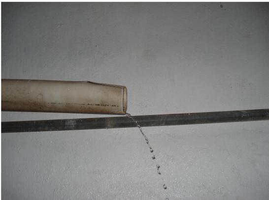
**FIGURA 27.** Excedente da caixa d' água.
