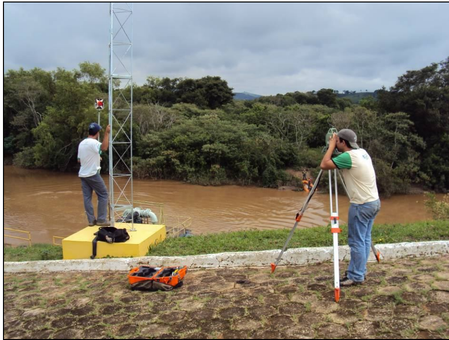
Figura 18. Foto da Estação total sendo utilizada para coleta de dados de topografia na seção Chapadão no rio Sapucaí Mirim, em Pouso Alegre/MG.
