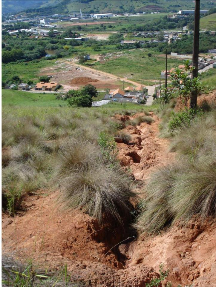
Figura 4. 8. Processo erosivo na parte superior não pavimentada da Rua Dr. Laércio Sanches.
