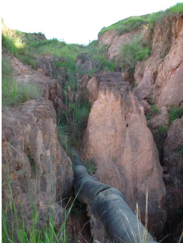
Figura 4. 7. Tubulações de escoamento pluvial presentes na voçoroca da Rua Oito.
