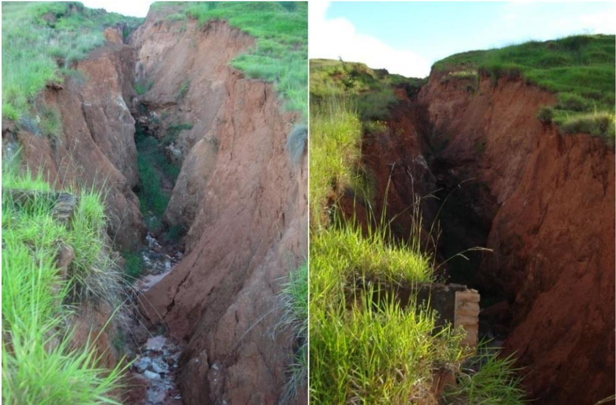
Figura 5. 2. Evolução do processo erosivo com aprofundamento significativo da voçoroca na Rua Oito entre os anos de 2012 e 2013.
