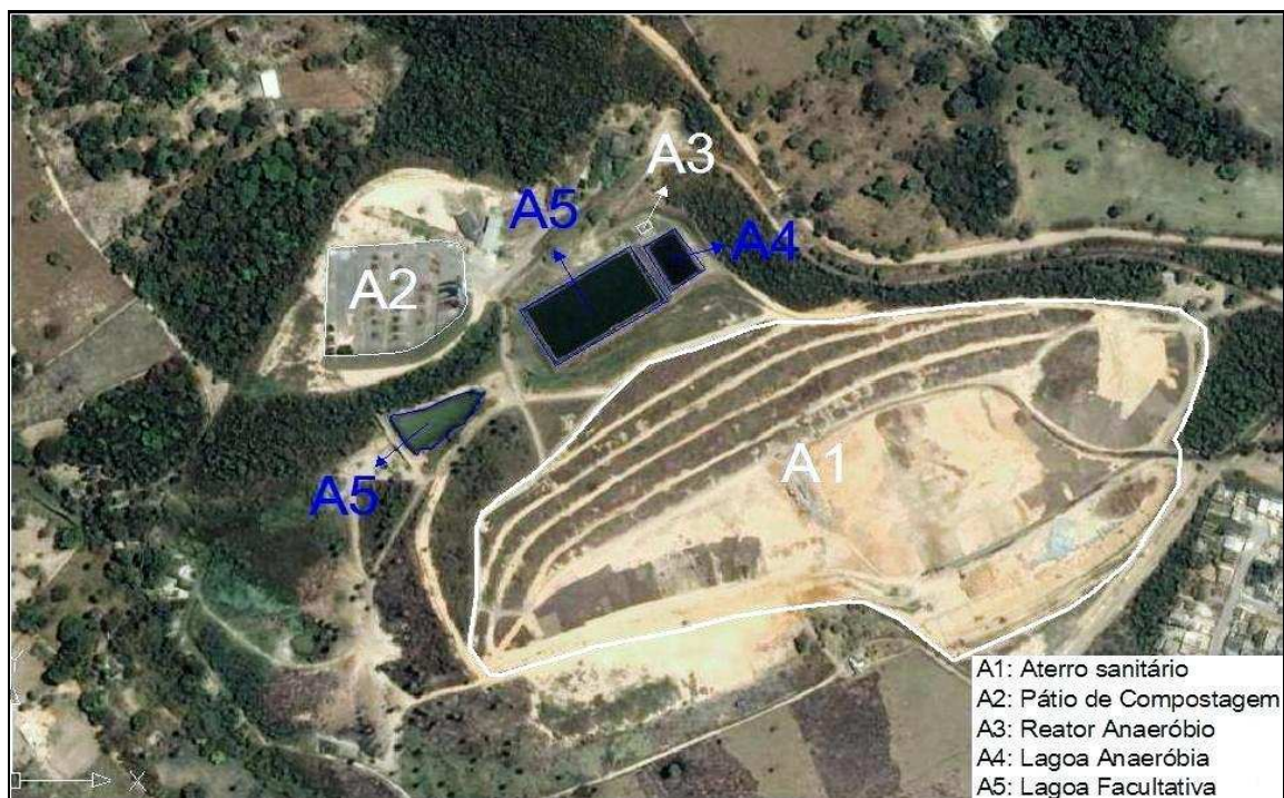
Figura 4.2. Imagem de satélite do Aterro Sanitário de Betim- MG (coordenadas: 579.786,22 m E; 7.786.474,23 m S, 23K) (Fonte: Google Earth, 2008)
