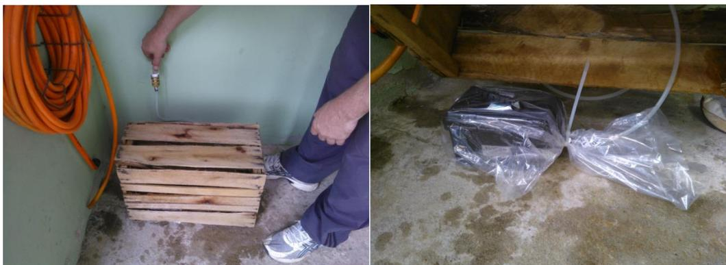
Figura 34 – Foto do medidor de pressão, data logger, instalado em uma das residências no bairro Água Branca.
