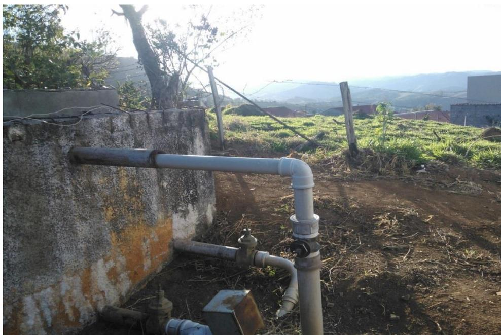
Figura 17 – Tubulação da sobra de água que chega ao reservatório tipo caixa no R4.
