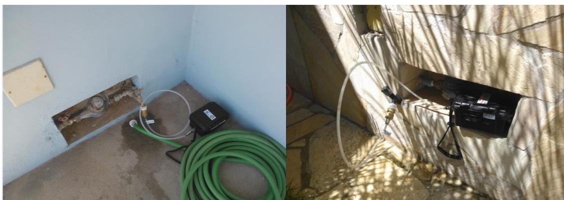
Figura 38 – Foto do medidor de pressão, data logger, instalado em duas das residências no bairro Vale das Rosas.
