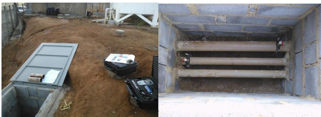
Figura 33 – Caixa construída para alocação dos equipamentos: Ultrassom (medidor de vazão) e Data logger (medidor de pressão manométrica).
