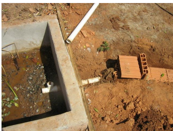
Figura 6.34. Vala de infiltração com tijolos cerâmicos vazados.
