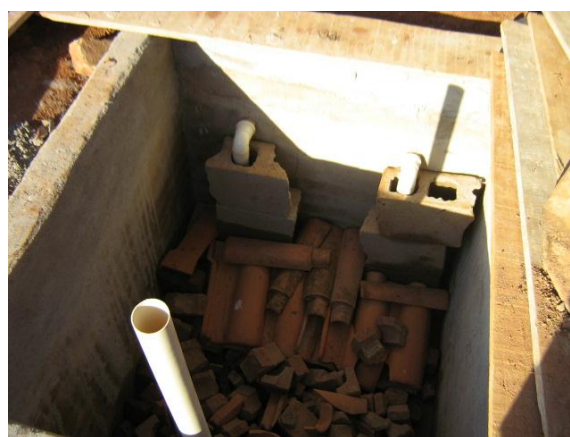
Figura 6.31. Esboço do sistema de tratamento de águas pretas.
