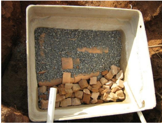
(a) reaproveitamento de caixa d'água obtida em ferro velho e sobras de material de construção.
