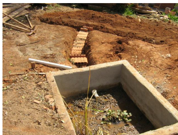
Figura 6.34. Vala de infiltração com tijolos cerâmicos vazados.
