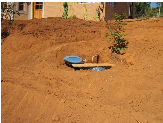
(e) tanque de reserva de água. Figura 6.6. Construção do filtro.
