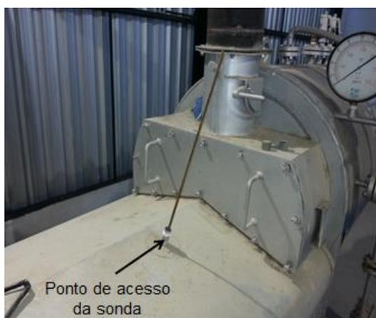
Figura 80: Ponto de inserção da sonda na parte superior da câmara de combustão.
