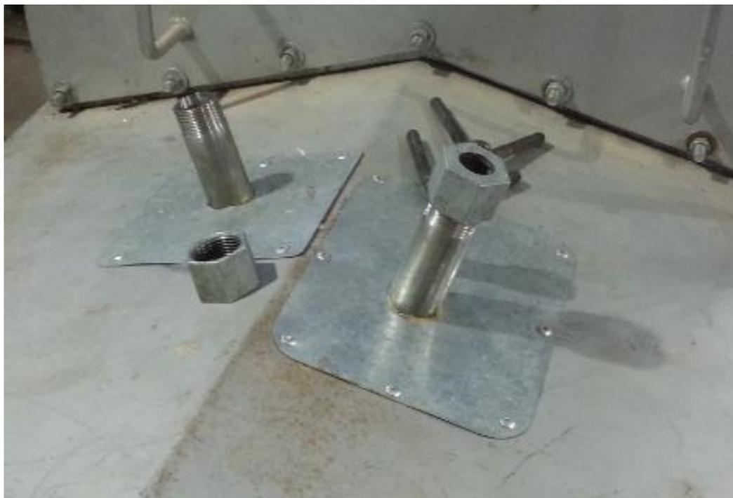
Figura 138: Acessos com guias prontos no teto da câmara de combustão.
