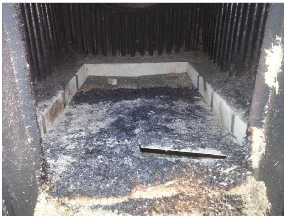
Figura 145: Distribuição das cinzas na grelha dentro da câmara de combustão após teste 1.
