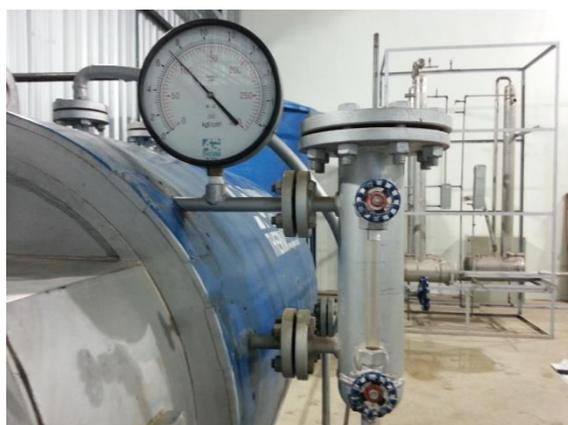
Figura 6: Caldeira em operação, manômetro registra  $7 \text{ [kgf/cm}^2]$ .
