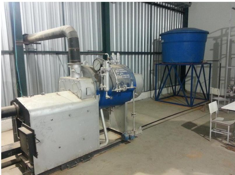
Figura 90: Caldeira com a caixa d'água instalada.
