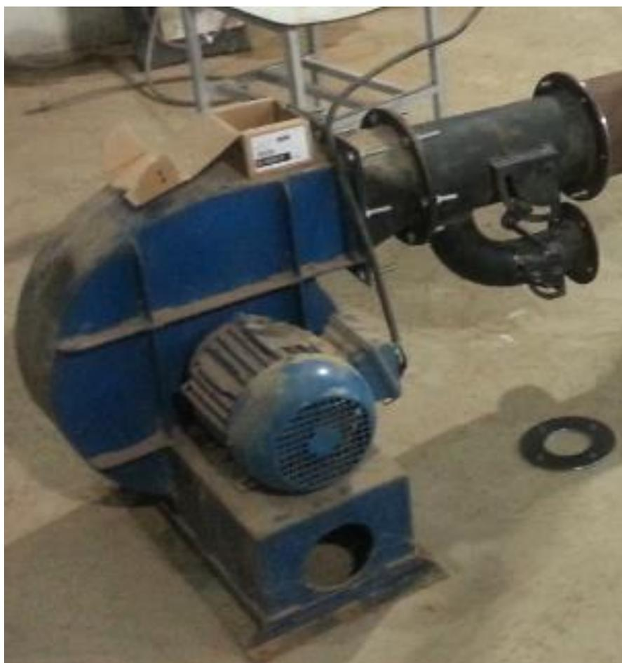
Figura 141: Soprador e bifurcação de ar em primário e secundário com dampers tipo “abre e fecha”.
