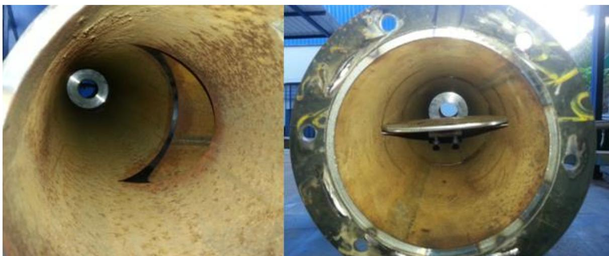
Figura 128: Vista da placa de orifício à montante e à jusante na tubulação de ar primário.
