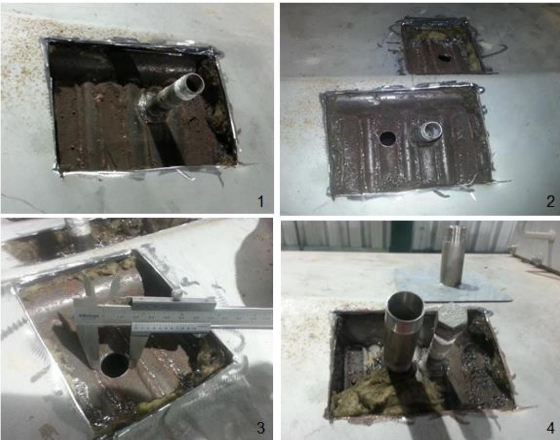
Figura 137: Sequência de construção dos acessos no teto da câmara de combustão.
