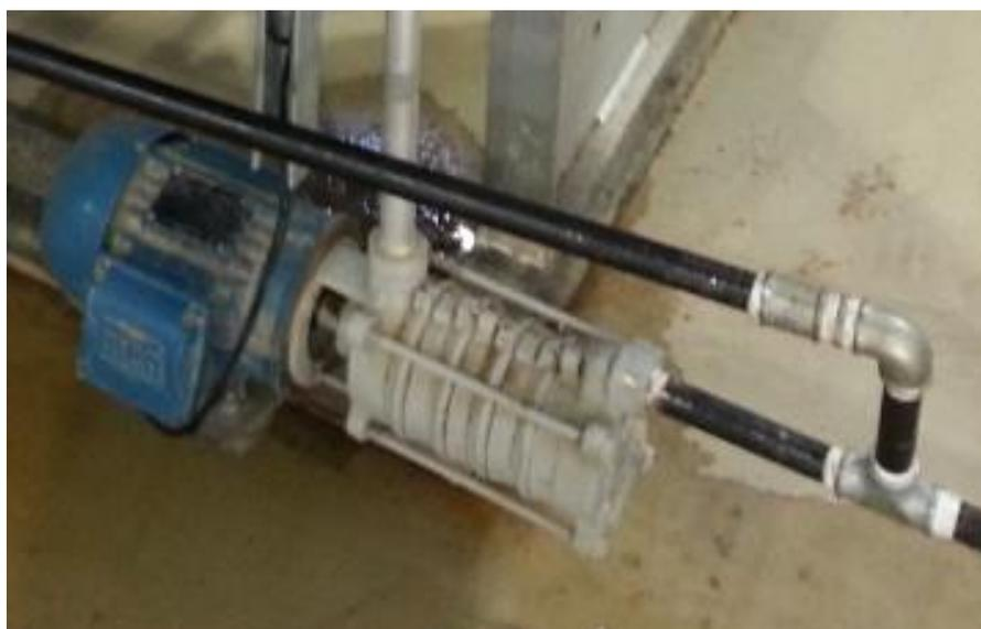
Figura 66: Bomba d'água já com a conexão de água em destaque na caldeira.
