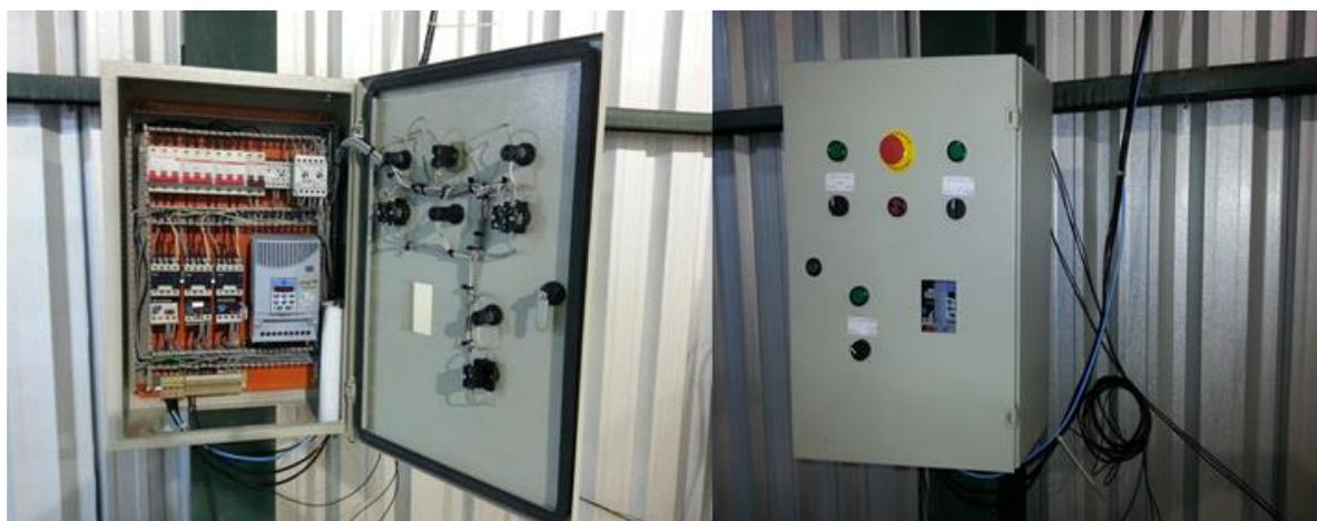
Figura 91: Quadro de força instalado na caldeira.
