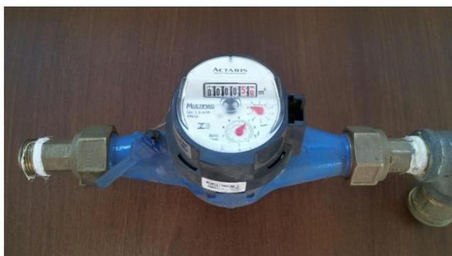
Figura 74: Medidor de vazão Actaris classe B.
