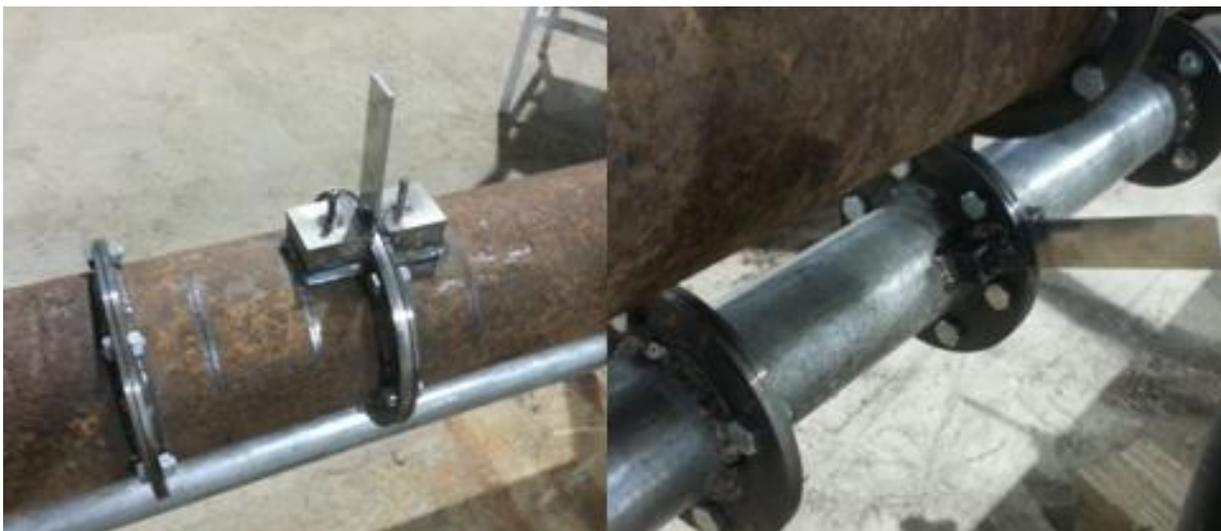
Figura 129: Placas de orifício instaladas nas tubulações de ar primário e secundário.
