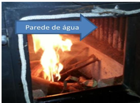
Figura 45: Parede de água da fornalha.
