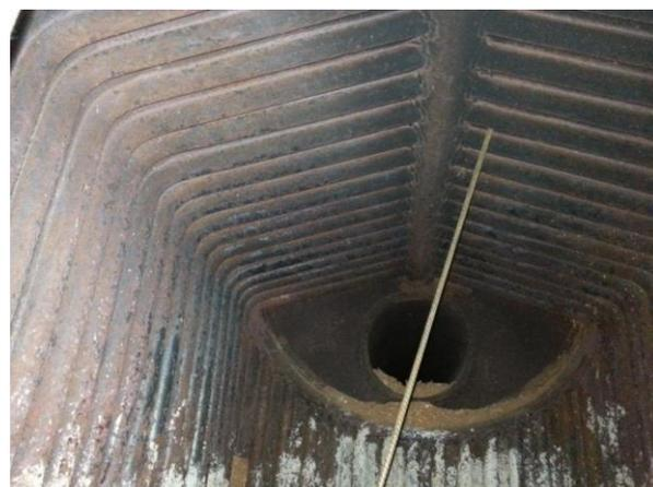
Figura 81: Ponto de inserção da sonda na parte interna superior da câmara de combustão.
