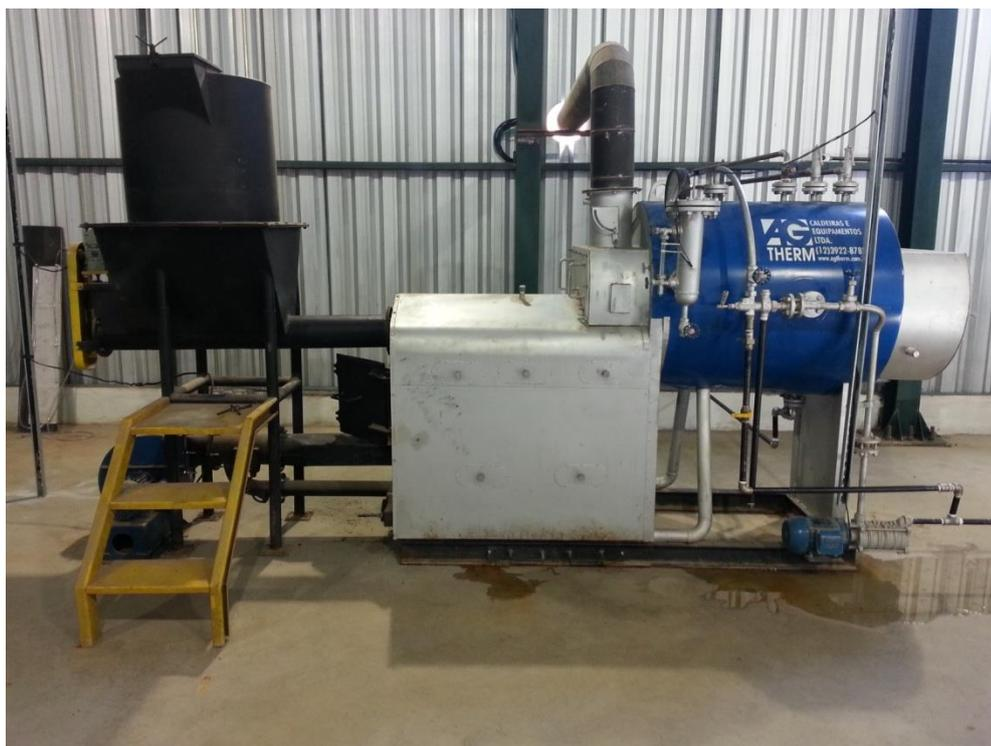
Figura 43: Foto da caldeira reformada e pronta para testes.
