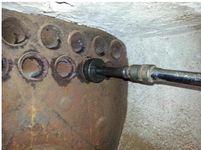
Figura 5: Operação de mandrilagem nos tubos da caldeira.
