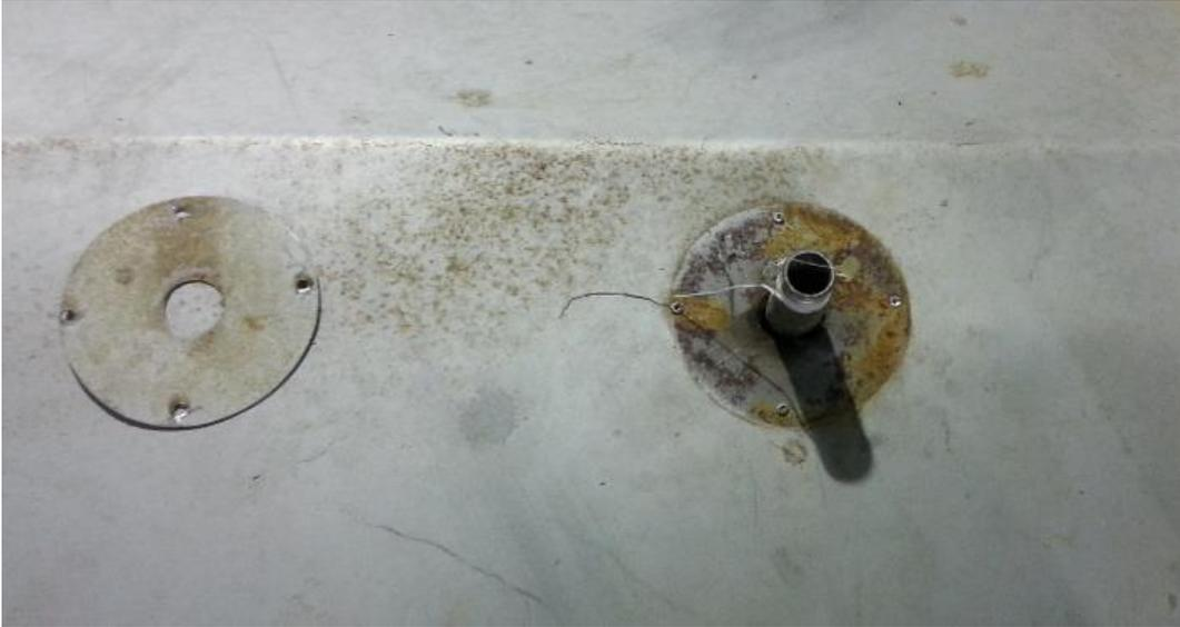
Figura 136: Acesso original no teto da câmara de combustão.
