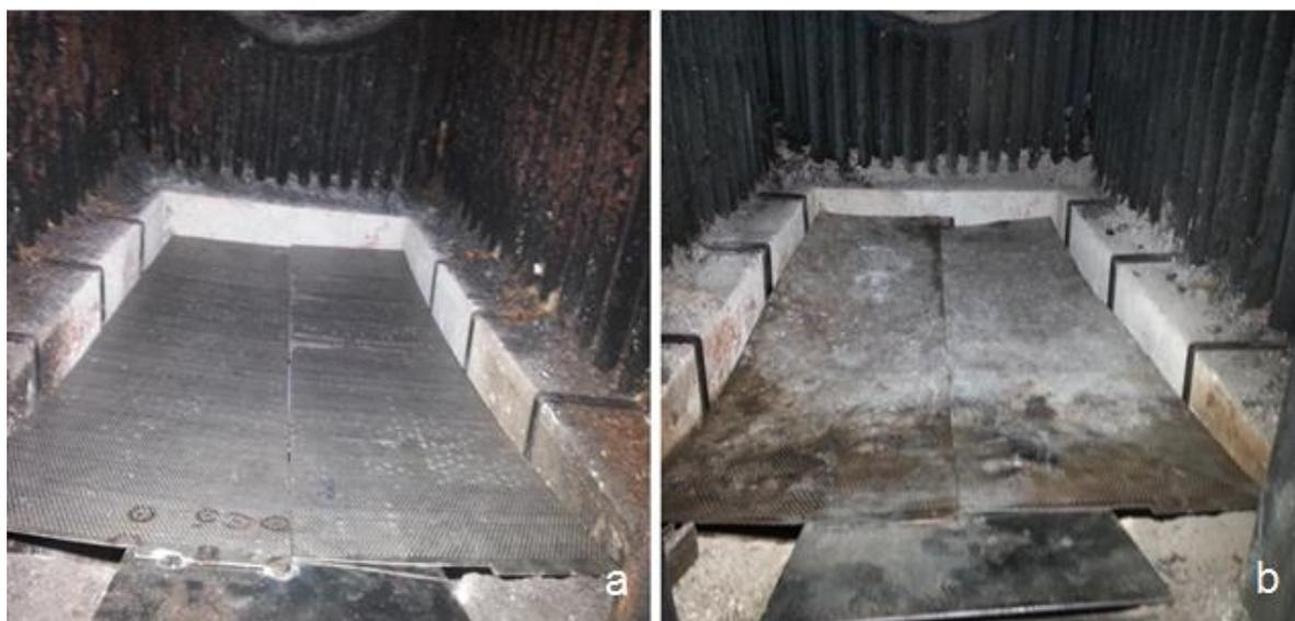
Figura 96: Grelha assentada nos suportes de 10 [mm] (a) e de 20 [mm] (b).
