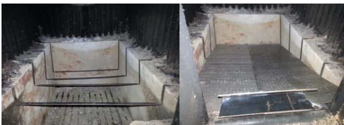
Figura 148: Posicionamento dos suportes e da grelha inclinada.
