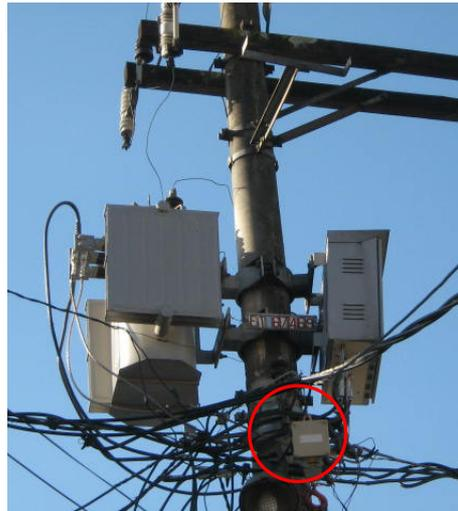
Figura 2.32 – Equipamento de medição MUG ELO 2160 instalado na comunidade de Paraisópolis.
