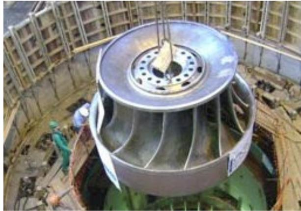
Figura 20 – Turbina Francis com eixo vertical
