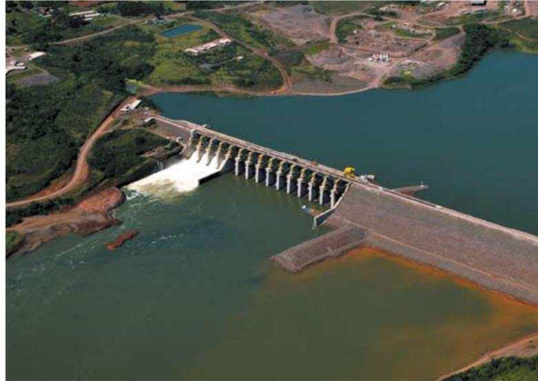
Figura 8 - Barragem de enrocamento: UHE Foz do Chapecó (Brasil)
