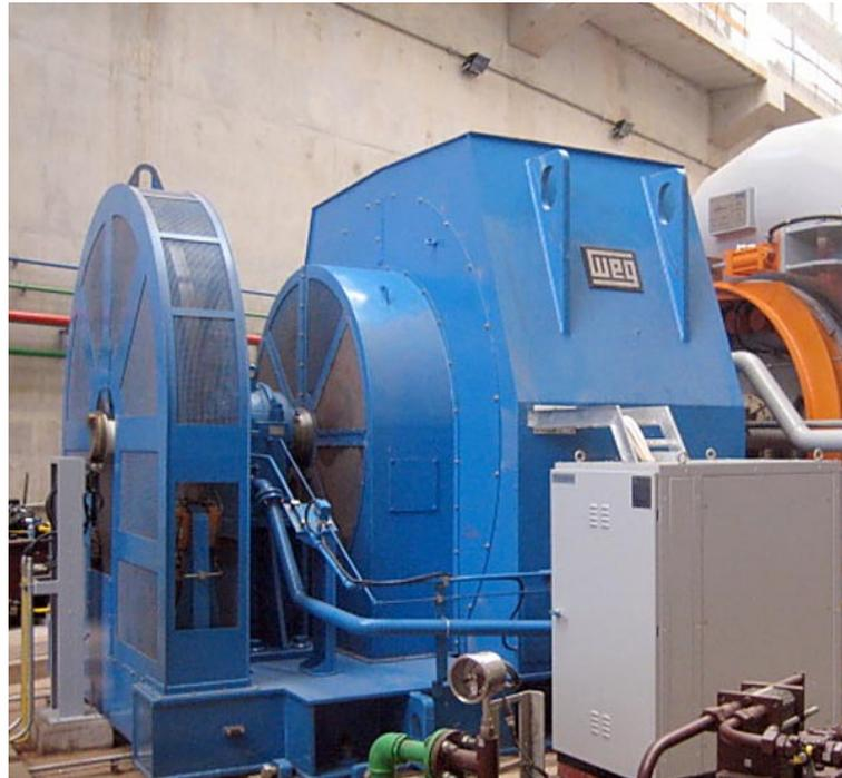
Figura 25- Hidro gerador elétrico
