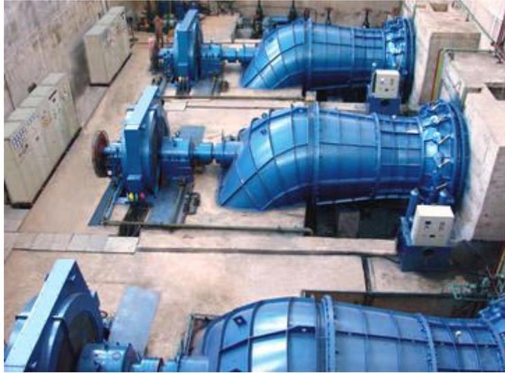
Figura 23 - Turbina hidráulica tubular
