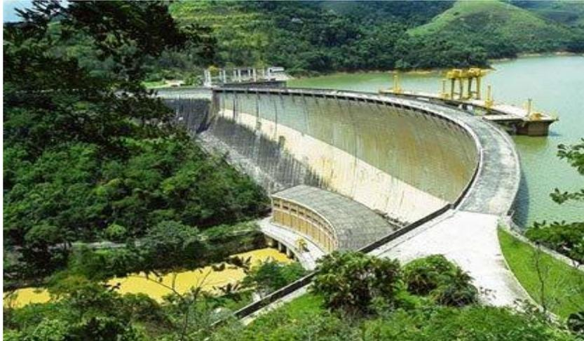
Figura 6 - Barragem em arco: UHE Funil (Brasil)
