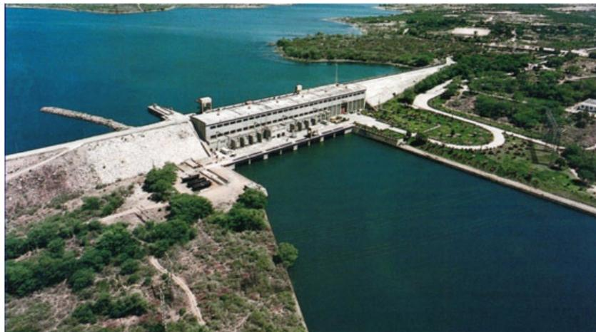
Figura 10 - Barragem mista: UHE Sobradinho (Brasil)
