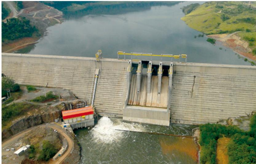
Figura 5 - Barragem de concreto à gravidade UHE Mauá (Brasil)
