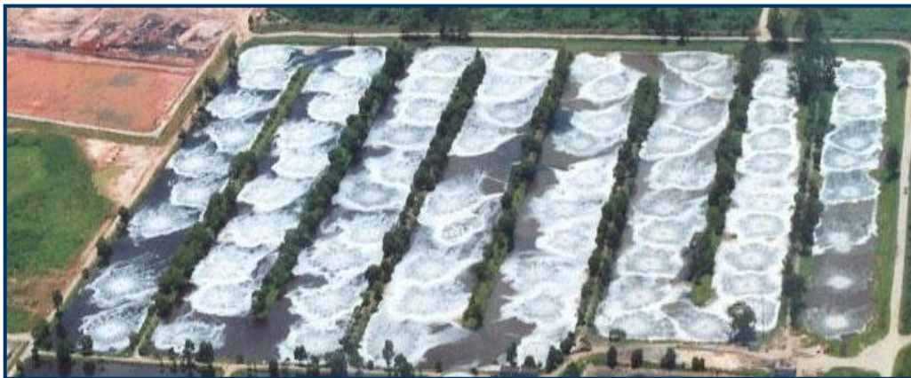
Figura 2.13 - Conjunto de lagoas do tratamento secundário. Fonte: Suzano, (2006).
