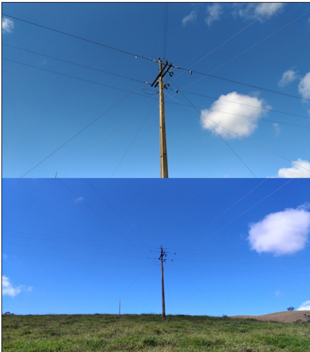
Figura 55 – Ponto de instalação dos sinalizadores.
