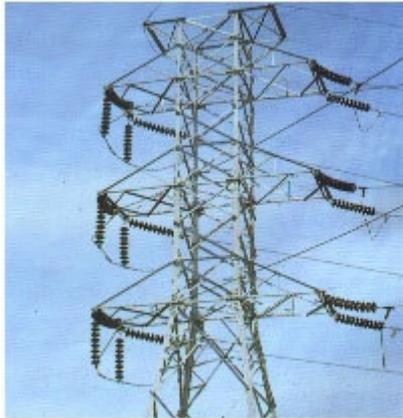
**Figura 147 - Isoladores para transmissão tipo suspensão.**
