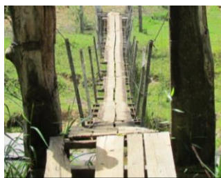
b) Ponte de acesso da população
