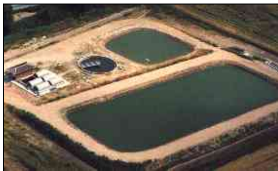
Figura 2.4: Lagoa Anaeróbia. Disponível em < http://www.geocities.com/jerr922/tran.html >, Acesso em Jan de 2006.
