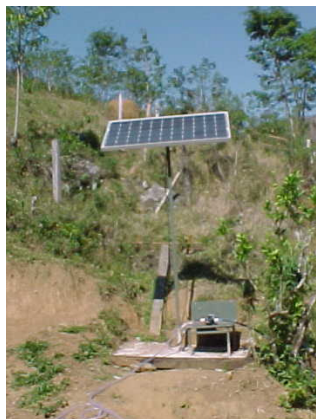
Figura 6.11 – Sistema fotovoltaico painel – carga.
