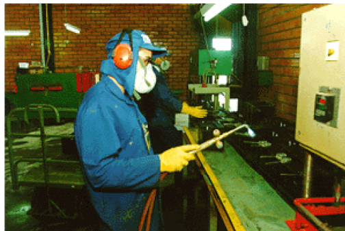
Figura 6.36 – preparação dos conectores para a bateria.
