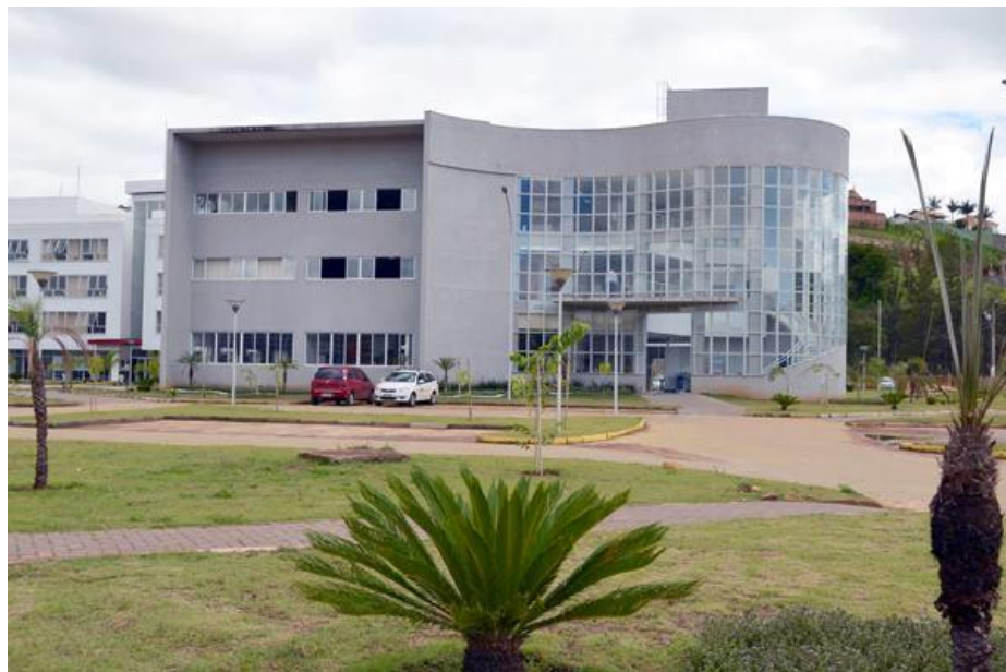
Figura 5.5 – Centro de Excelência em Redes Elétricas Inteligentes (CERIn).
