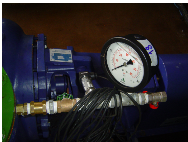
FIGURA 71 - Transdutor de pressão e manômetro de Bourdon, entrada da BFT
