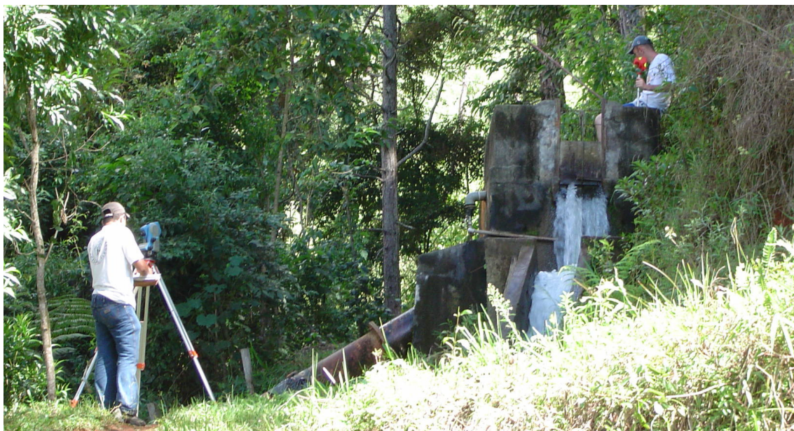
FIGURA 45 - Levantamento topográfico utilizando estação total
