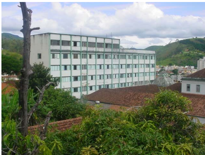
Figura 6.3 – Fotografia do Bloco 3 – Internação (prédio novo). Fonte – Dados da pesquisa, 2007.
