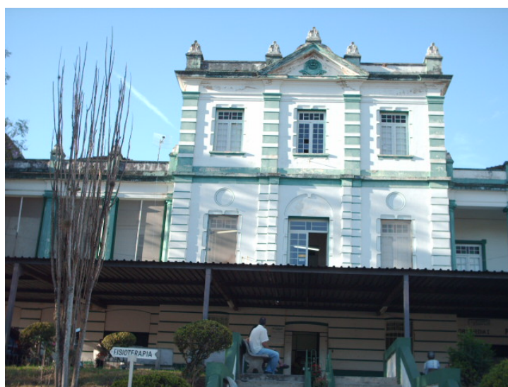
Figura 6.2 – Fotografia do Bloco 2 – Pronto socorro (prédio antigo). Fonte: Dados da pesquisa, 2007.
