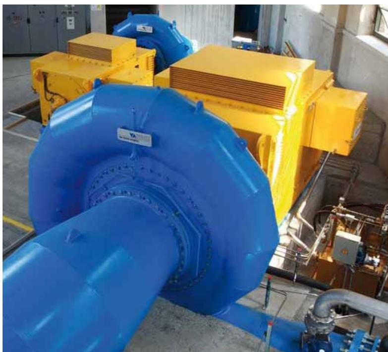
**Figura 24 – Turbinas Francis. - Fonte va tech hidro magazine (2009)**
