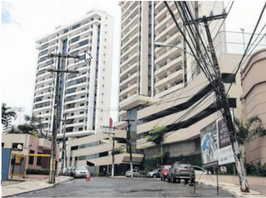
Figura 2-11 – Foto do poste com a angulação incorreta.
