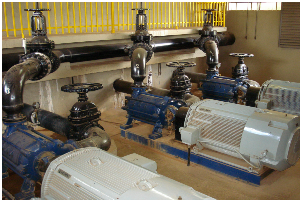
Figura 4.14 - Alto Recalque da EEAB Rio Grande 3 x 550CV x 4,16 KV
