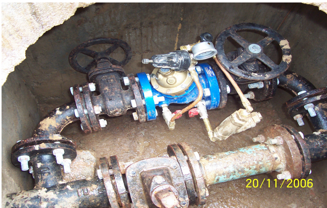
Figura 4.19 – Válvula Redutora de Pressão auto operada 2”.
