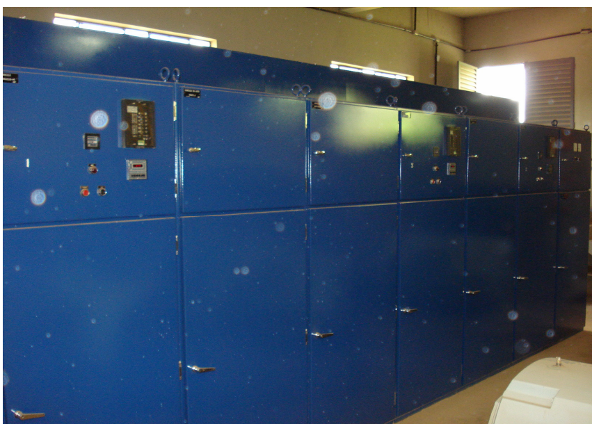
Figura 4.13 - Quadro de comando 3 x 4,16 kV usado para acionamento do Alto Recalque
