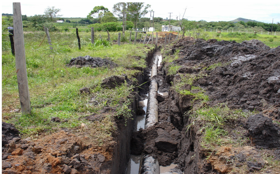
Figura 4.7 – Implantação Adutora Água Bruta EAB002 Santa Cruz Fonte:Arquivo fotográfico Copasa de lavras.
