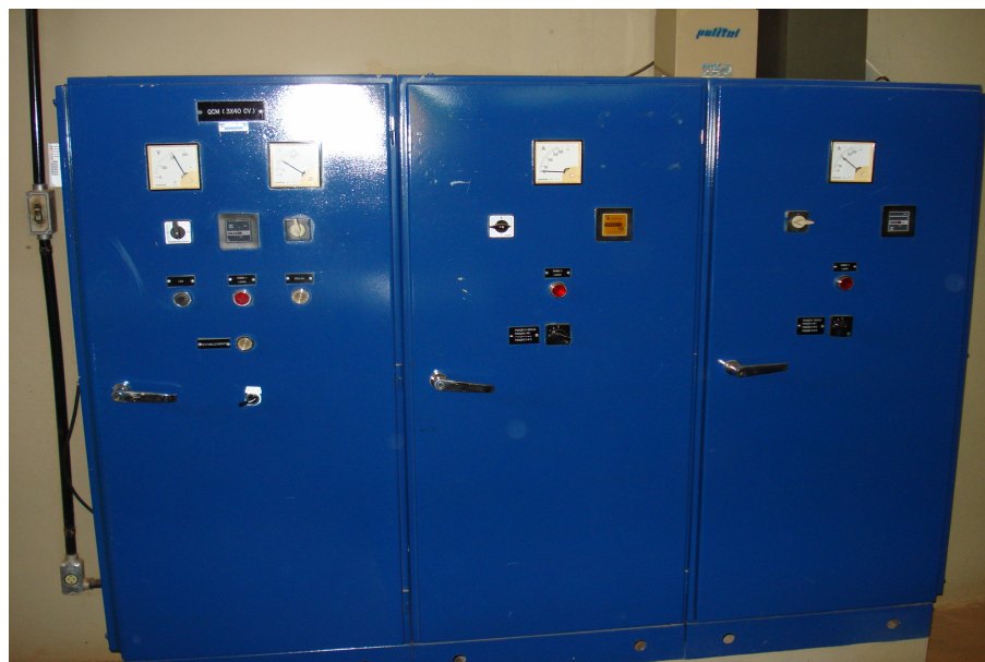
Figura 4.11 - Quadro de comando para motores 3 x 40cv x 220 v usado no acionamento dos conjuntos do Baixo Recalque Fonte: Arquivo fotográfico Copasa de Lavras
