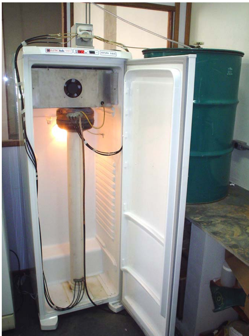
Figura 13 – Reator UASB instalado dentro de uma incubadora no LACONFIQ
