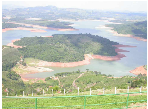
Figura 7.31 - Vista do reservatório em período de deplecionamento (Fonte: Foto tirada no local pelo autor).
