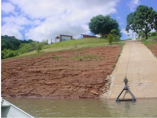
Figura 7.32 - Represa de Caconde deplecionada em 12 m, em novembro de 2005.
