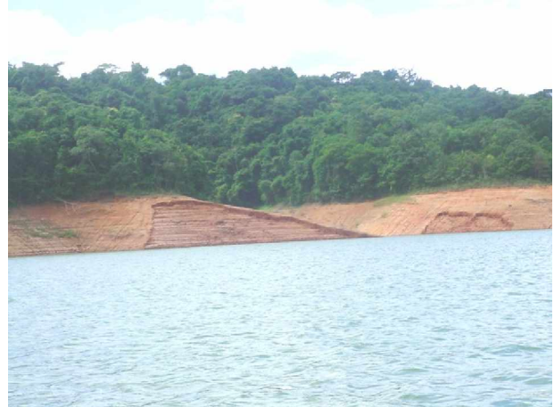
Figura 7.33 – Erosão do solo a partir do deplecionamento da represa (Foto tirada em campo, novembro de 2005).
