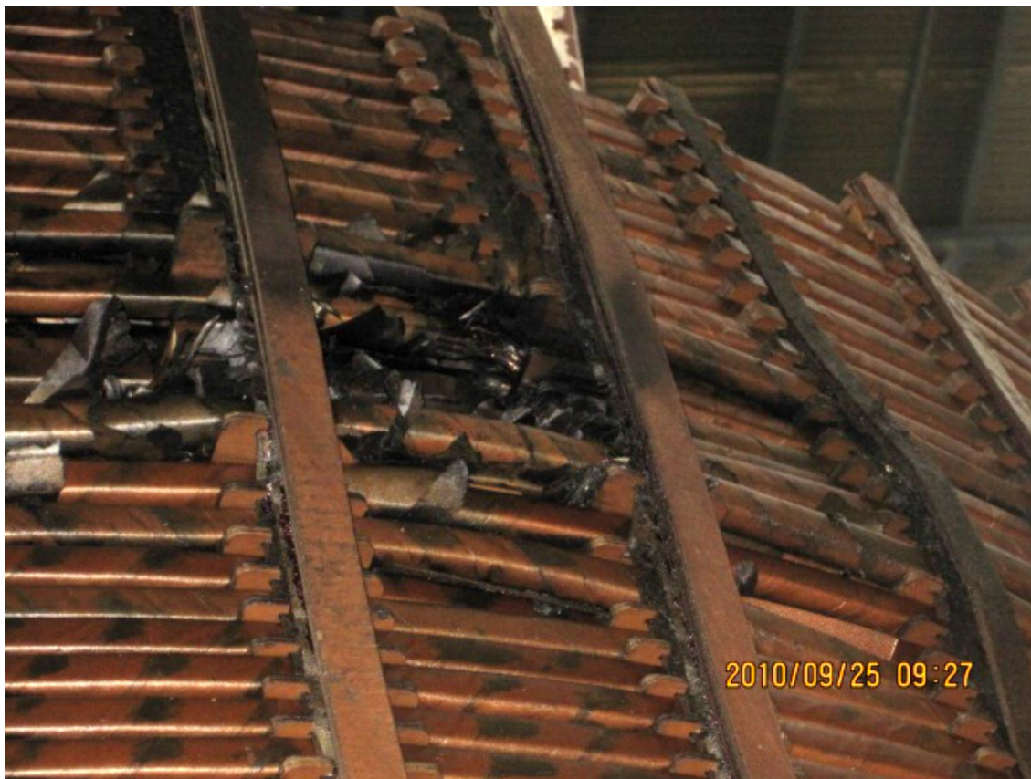
Figura 3.28 - Inspeção visual da avaria do transformador.
