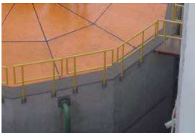
Fig.6.14 – Trecho da estrutura de concreto
