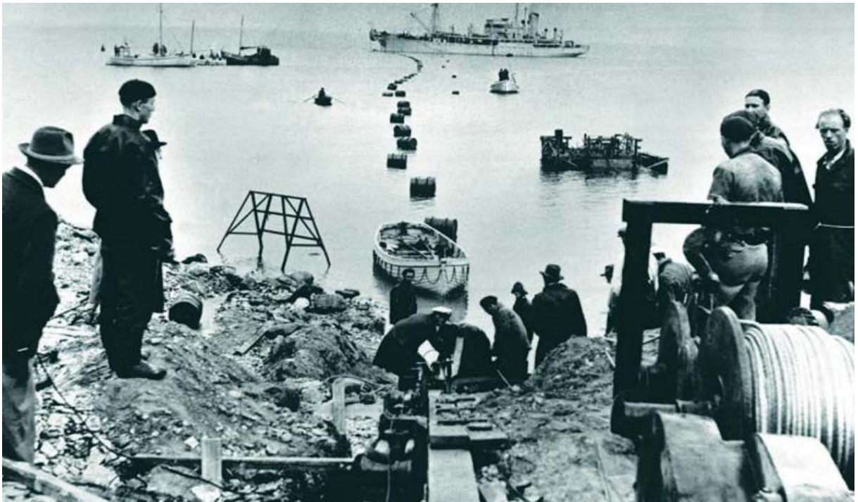
Figura 2.4 – Comissionamento do 1º link HVDC 1954 [16].
