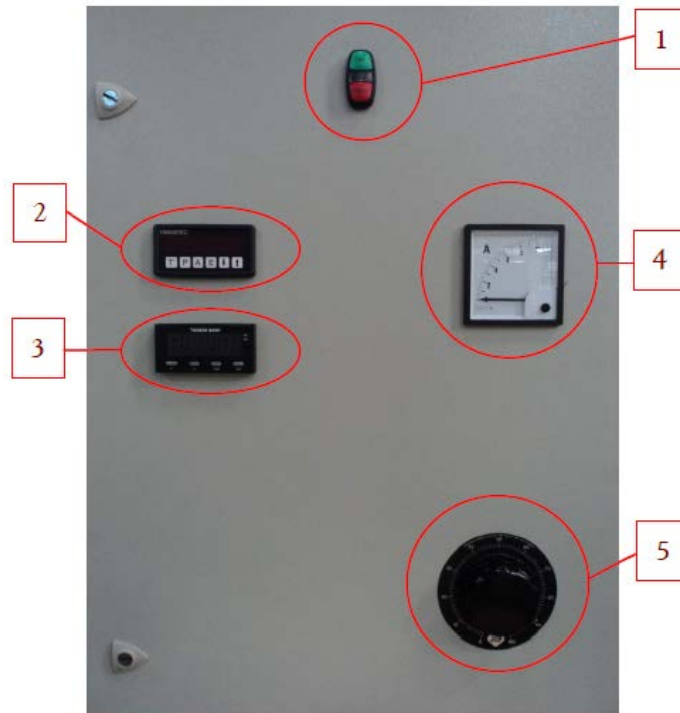
Figura 4.4 – Excitatriz Estática e Instrumentos de Medição.
