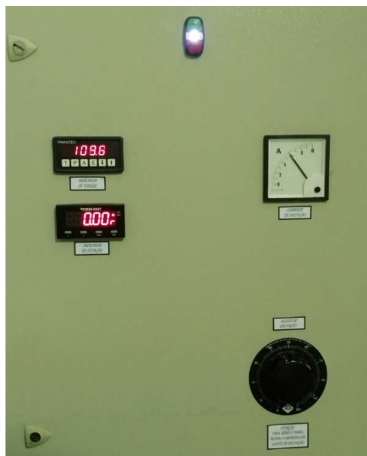
Figura 4.5 – Excitatriz Estática e Instrumentos de Medição em operação.
