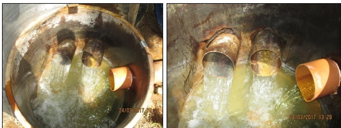
Figura 12 - Ponto de medição da caixa de saída dos efluentes oriundos da produção do trinitrotolueno e nitrocelulose. Fonte: Própria.
