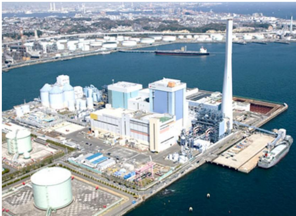
Figura 4.20 - Planta a carvão Isogo de 1200 MW localizada no Japão. Fonte: (ELETIC POWER DEVELOPMENT, 2009).
