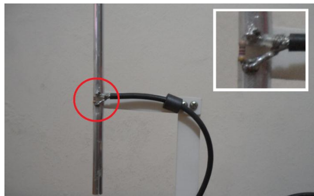
Fig. 6.5 – Antena dipolo com a resistência instalada.
