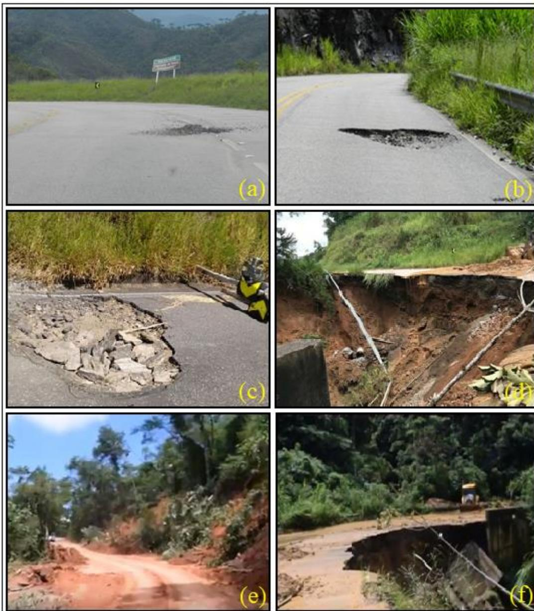
Figura 34: Problemas com buracos e deslizamentos na RJ - 163. (a), (b) e (c) Buracos na RJ-163; (d), (e) e (f) Deslizamento de encostas na RJ-163. Fontes: (a) e (b) Foto tirada em trabalho de campo em 2017; c) <https://avozdacidade.com> (2018); (e) e (f) <http://porteiradomato.com.br/blog/page/22/> (2018).
